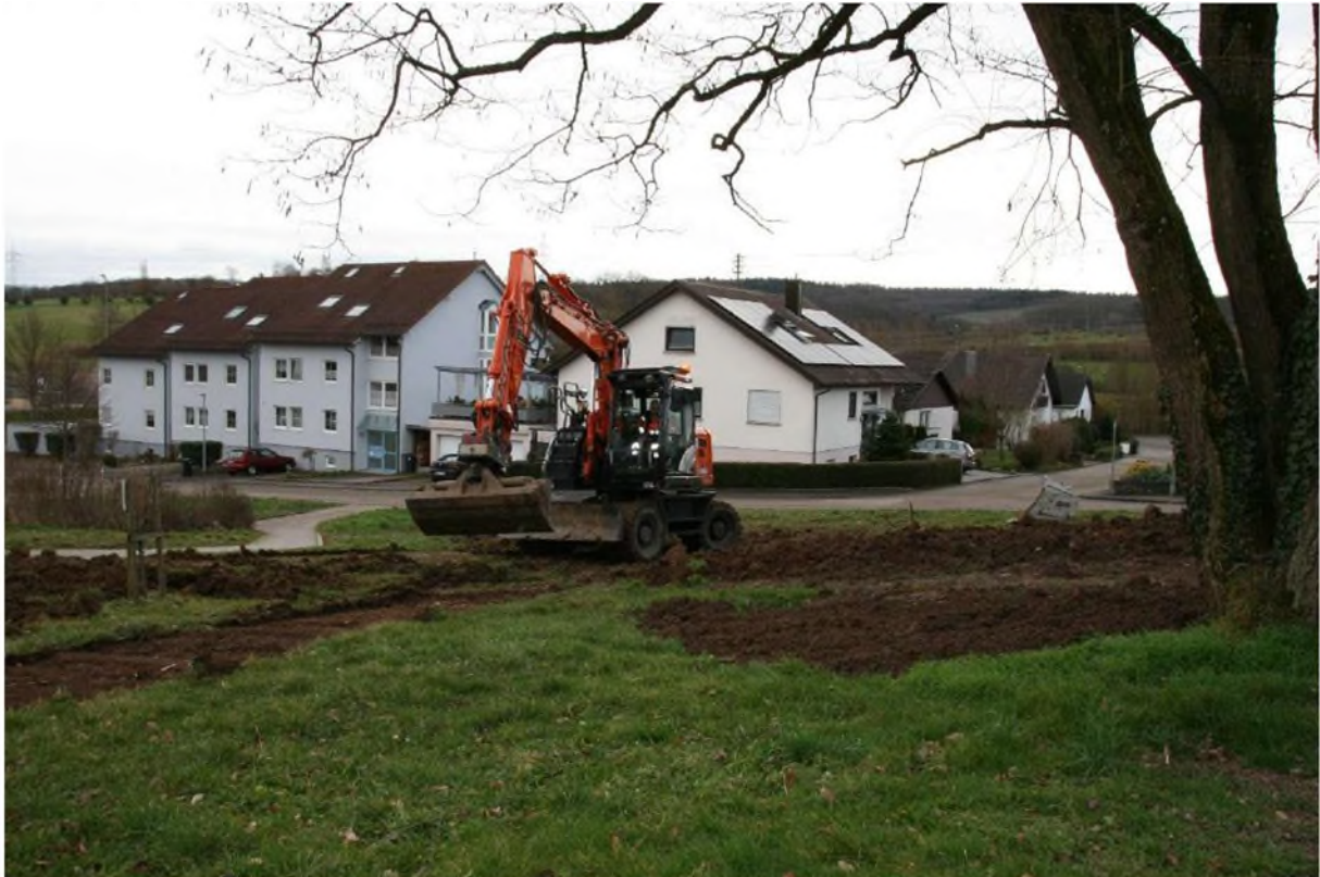
Vorbereitung des Bodens 1
