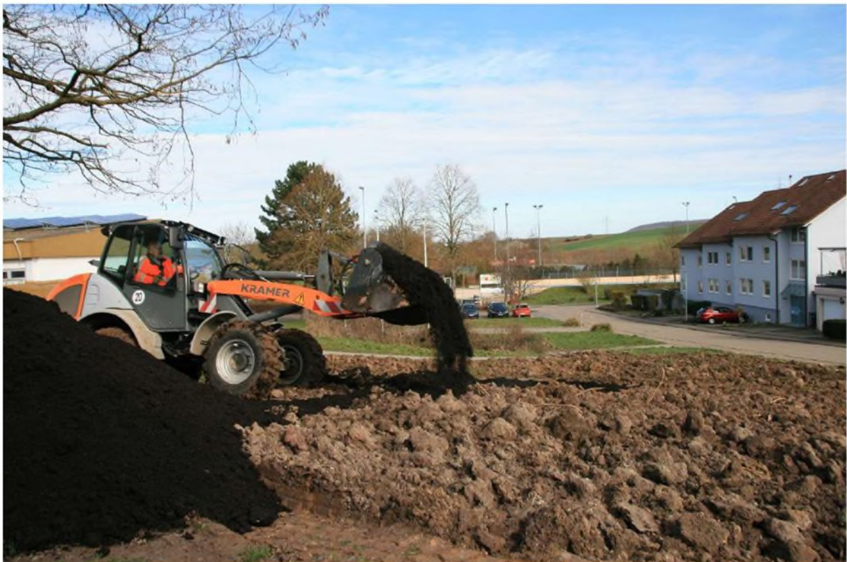
Vorbereitung des Bodens 2
