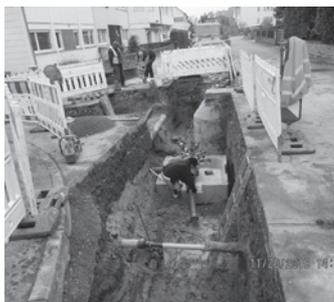
Der Einbau der Schieber und Armaturen, sowie die Erneuerung der Anschlussleitungen
