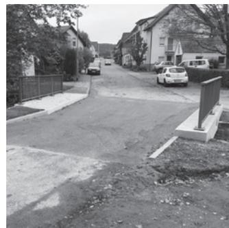
tragfähigem Flüssigboden bis auf die Höhe des Erdplanums verfüllt. Im Bereich der Fahrbahn mussten neue Schrammborde und Geländer nachgerüstet werden, da diese nicht mehr den aktuellen Regeln der Technik entsprachen bzw. gar nicht vorhanden waren. Im Zuge dieser Sanierung sollte auch der talseitige Gehweg
