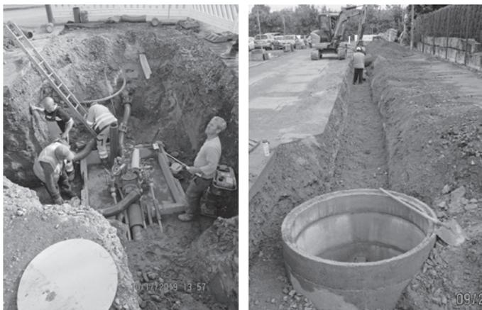
die Verlegung der neuen Wasserleitungsrohre und der Einbau der Schieber und Schachtformstücke durch die städtischen Wassermeister.
