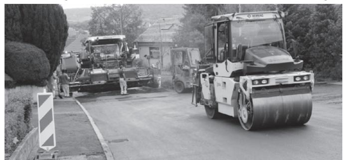
und starken Rissen muss punktuell auch die Asphalttragschicht und der Unterbau erneuert werden. Weiterhin wurden vorab Bordsteinabsenkungen behoben sowie Schachtabdeckungen und Straßeneinläufe angepasst bzw. erneuert.
