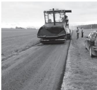
Binsen“ auf einer Länge von ca. 400 Meter eine neue Tragdeckschicht mit einer Stärke von 8 cm eingebaut.
