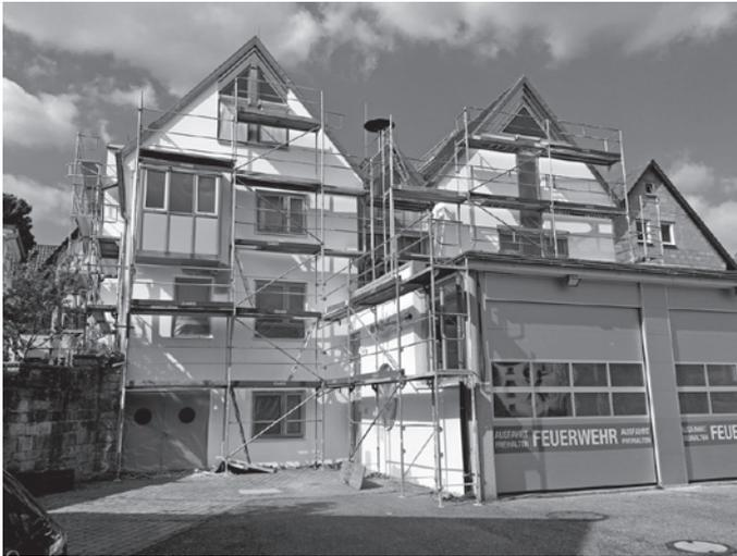
Dieser zusätzliche Raum wird für die neue Fahrzeuggeneration bei der Feuerwehr Stetten auch dringend benötigt. Nach Einbau der neuen Tore waren zudem Elektro-, Gipser- und Malerarbeiten, Fliesenarbeiten sowie Arbeiten an der Lüftungsanlage notwendig. Die Feuerwehr Stetten konnte den zusätzlichen gewonnenen Raum bereits beim Jubiläumsfest nutzen.
