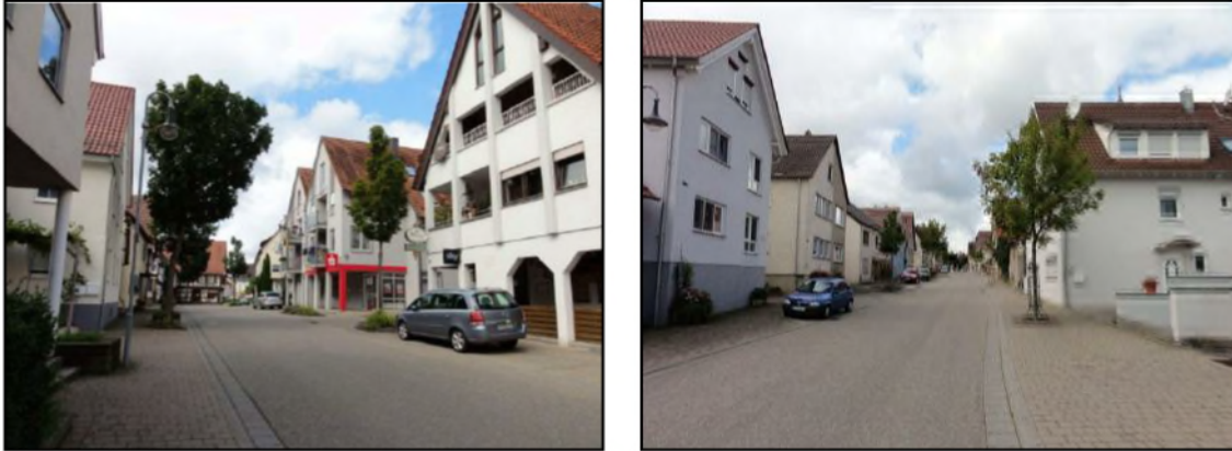
Abbildung 15 – Hauptstraße Höhe Nr. 17 (li) und Höhe Nr. 60 (re)
