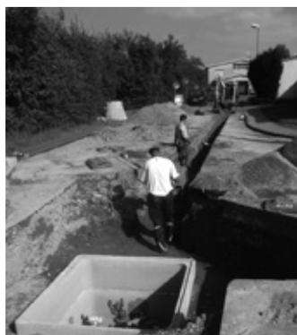
bindung zweier Sackleitungen (Ringschluss) in der Daimlerstraße beauftragt. Die Leitungsverlegung und Einbau der Schachtautomaten und Schieber erfolgte wie üblich durch die städtischen Wassermeister.
