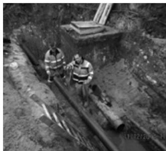
In der Steinhaldenstraße wurde beim Umbau eines Hydrantenschachtes infolge eines Rohrbruchs festgestellt, dass die parallel zur Versorgungsleitung verlegte Förderleitung zum HB „Rosenberg“ seitlich in den Hydranten-
