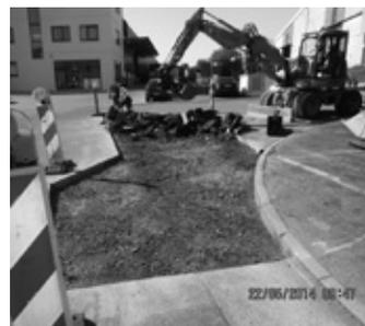
im Straßenbereich behoben werden. Zum Teil musste hier der komplette Asphaltaufbau ausgebrochen, der Straßenunterbau ergänzt und neu asphaltiert werden.
