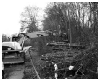
Bäume gefällt. Der Fällgreifer ist anstatt der Baggerschaufel am Bagger montiert und kann die Gehölze festhalten und entweder selbst abzwicken (hier sind Stammdurchmesser bis 20 cm möglich) oder aber Bauhofmitarbeiter sägen
