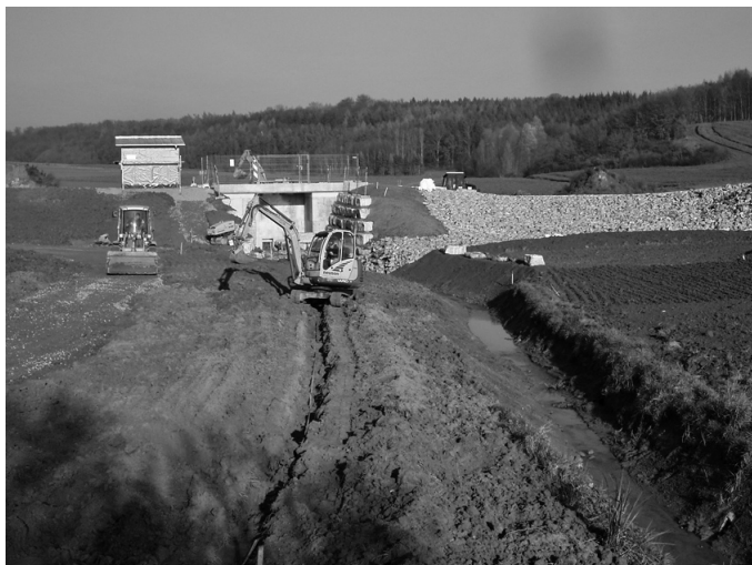
Arbeiten am Becken M4
