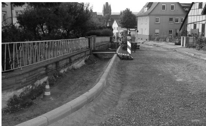
Arbeiten in der Mörikestraße
