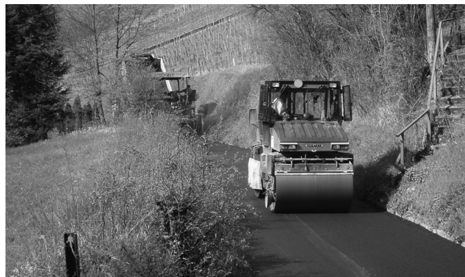
Sanierung des „Alte-Burg-Wegs“
