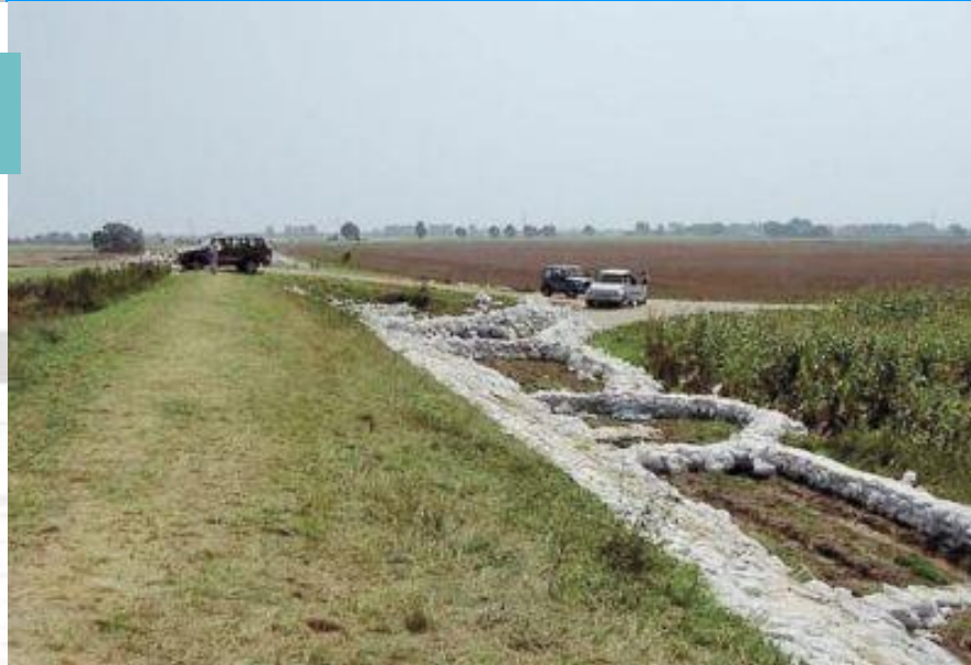
Auflastfilter mit Fangedamm
