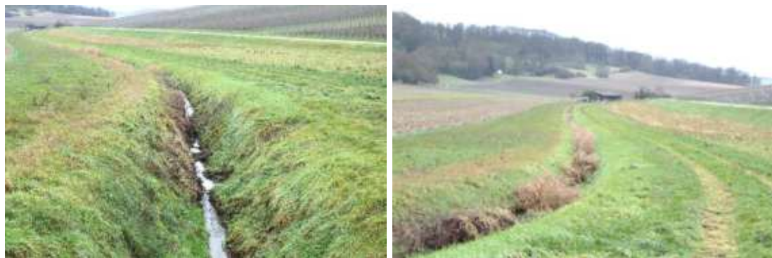
Sehr tief liegender, begradigter mit technischem Querschnittsprofil „ausgestatteter“ Schaufelsberggraben
