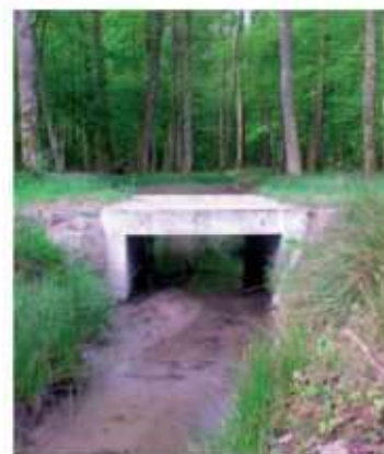
Abb. 3.8: Rechteckdurchlass (Betonrohr) mit durchgehender Sohle. An Schwelchenbereich Längssohlentiefen, künstliche Berme durch Auflandung, Tümpeln (EM)
