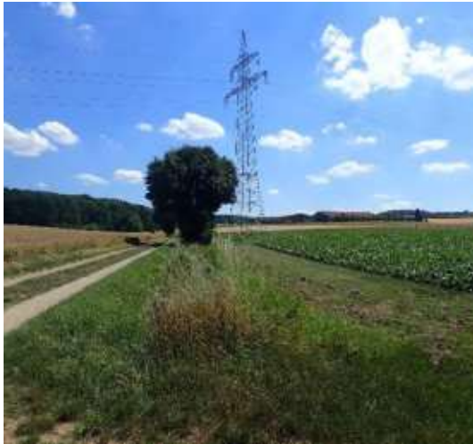
Ausgebauter Zochklingsgraben auf Gemarkung Schwaigern
