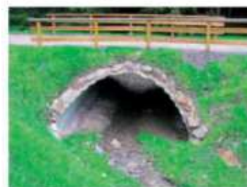
Abb. 3.7: Maßnahme erlaubt Gewässergestaltung im Bauraum
