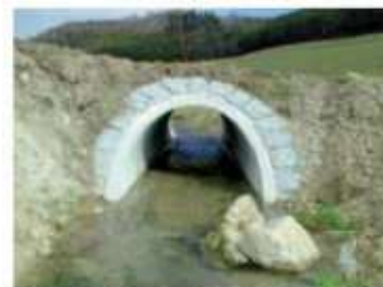
Abb. 3.6: Betonrohr ausreichend auf eingetragten, aquatische Durchgängigkeit verbleibend. Bermen und flache Überschnungen werden im angestrebten Durchgängigkeit herstellen.
