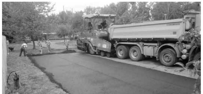
In der Woche ab 26.10.2015 soll in der Heinrich-Schütz-Straße in Massenbach der Asphaltbelag erneuert werden. Vorab wird dort der verschlissene Deckenbelag abgefräst. Weiterhin müssen Schachtabdeckungen, Bordsteine und Straßeneinläufe angepasst und zum Teil erneuert werden. Diese vorbereitenden Arbeiten sollen unter halbseitiger Sperrung durchgeführt werden. Der Anliegerverkehr kann hierbei größtenteils aufrecht erhalten werden.
