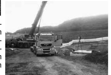
Zur Sicherstellung der Löschwasserversorgung wurde am vergangenen Freitag ein Löschwasserbehälter aus Stahlbetonfertigteilen mit einem Volumen von 200 m<sup>3</sup> mit einem Schwerlastkran versetzt.
