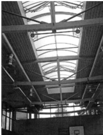
Anfang August wurde das 18 m x 3 m große, 25 Jahre alte Lichtband des Hauptdaches komplett erneuert. Hintergrund für die Sanierung war, dass die gewölbten Polycarbonat-Hohlkammerprofile porös wurden. Bei bestimmten Wetterlagen drang Wasser ein.
