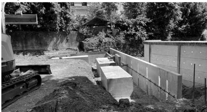
Diese Stützwand wird im Endzustand wieder teilweise in die vorhandene Böschung integriert und durch Stauden nahezu verdeckt sein. Parallel zu diesen Arbeiten wird derzeit auch mit dem Aushub der neuen Erdreichengräbern begonnen.
