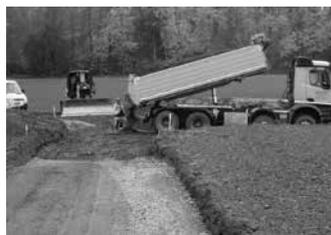
An der Gemarkungsgrenze Kirchhausen/Massenbach wird im Gewann „Haugen/Hammelsäcker“ durch den Bau eines 3 Meter breiten Asphaltwegs der Lückenschluss für eine befestigte Radwegverbindung zwischen Massenbach und Kirchhausen hergestellt.
