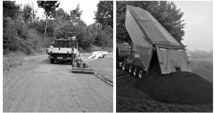
Aktuell wurde mittels einer handgeführten Kreiselegge das Material gelockert und anschließend das Unkraut mit dem Handrechen entfernt. Abschließend wird nun diese Woche noch eine dünne Lage Material nachgelegt, um Unebenheiten zu beseitigen und die Körnung der Deckschicht zu erhalten.
