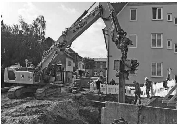
Ab der KW 35 ist geplant, mit den Hochbauarbeiten zur Herstellung der neuen Brücke zu beginnen. Dabei wird im ersten Schritt die überschrittene Bohrpfahlwand auf beiden Seiten mit 30 cm starken Vorsatzschalen aus Stahlbeton bis ca. 80 cm unterhalb des Gewässerlaufes verblendet. Diese Vorsatzschalen entsprechen dann auch der späteren Durchlassbreite des Leinbachs im fertigen Zustand der neuen Brücke.
