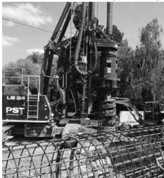
Im ersten Schritt werden jetzt auf beiden Seiten des Leinbachs insgesamt 22 Bohrpfähle errichtet, wobei laut geologischem Gutachten 6 Pfähle auf jeder Seite in eine Tiefe von ca. 9 m bis auf tragfähigen Baugrund geführt werden müssen. Die Bohrpfähle aus Beton und Stahlbeton bilden dann das Fundament der neuen Brücke in Form einer überschnittenen Bohrpfählewand.
