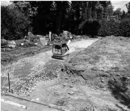
Parallel zu diesen Arbeiten wird am Urnengrabfeld UR 1 ein 1,60 m breiter Weg für einen besseren Zugang neu angelegt. Unter der Linde am oberen Ende des Weges wird ein Sitzplatz entstehen.
